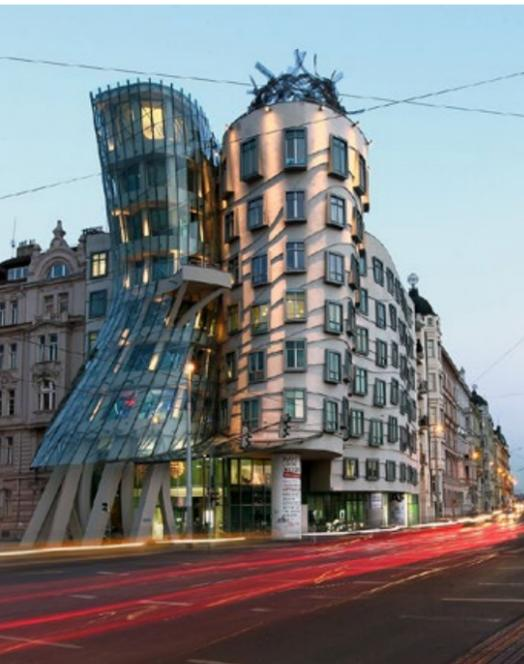
La maison dansante est composée de 99 panneaux de béton de formes et de dimensions différentes, ayant nécessité le recours au coffrage bois. Les deux cylindres qui forment les deux parties de l'immeuble sont placés côte à côte dans un effet de mouvement. Ici, Gehry s'inspire des deux danseurs Tchèques Fred et Ginger. On reconnaît bien les formes élancées de Ginger et la silhouette en V de Fred.
